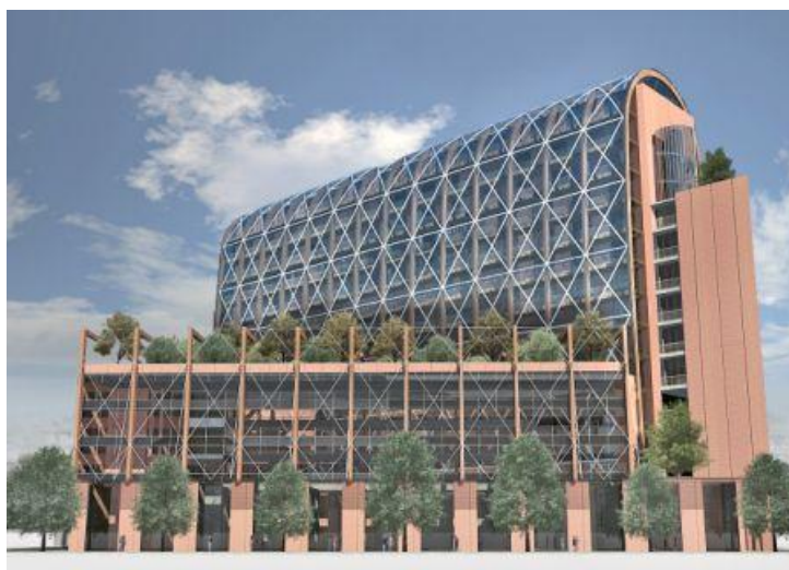
Edificio del gruppo Ligresti in costruzione
